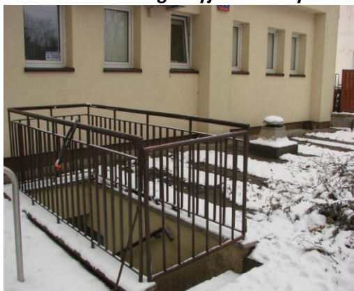
Widok dodatkowego wyjścia z budynku
