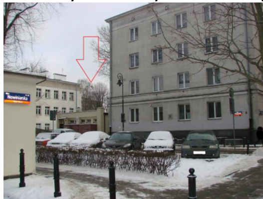
Widok budynku od strony ul. Nowiniarskiej
